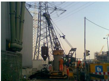
Gegreiferte Bohrpfahlwand unter beschränkter Höhe
