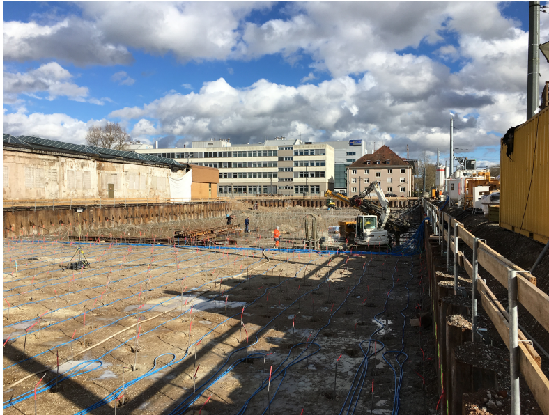
Ankerarbeiten und Weichgelinjektion
