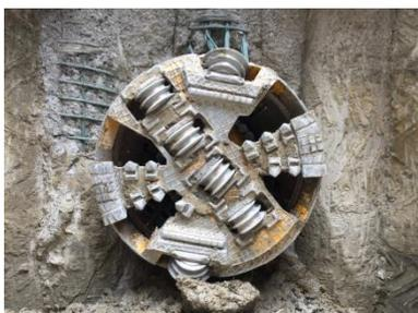
Mischboden-Schneidrad nach Durchstich
