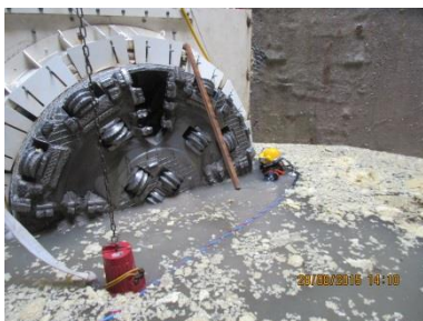
Lenzen Zielschacht nach Durchstich
