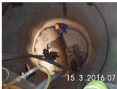
Anschluss Zwischenschacht an Kanal
