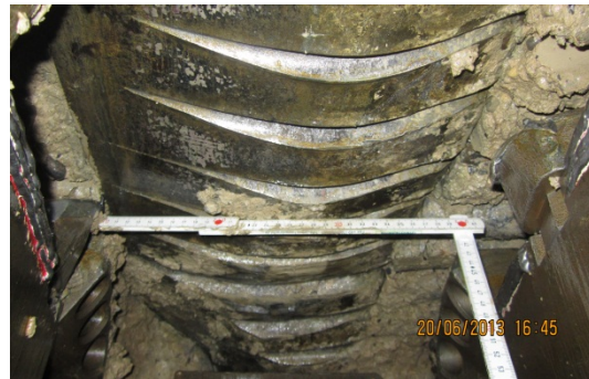
Stahlhindernis an der Ortsbrust
