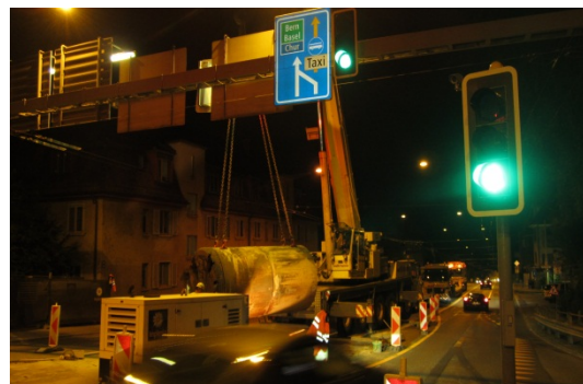
Bergen der TBM in Nachtarbeit
