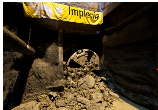
Durchstich des 2. Vortriebs
