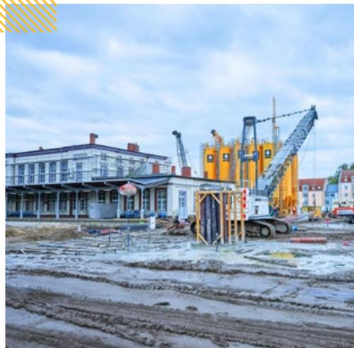
Ludwigslust, Deutschland: Implenia führt für die neue Eisenbahnüberführung Spezialtiefbauarbeiten aus.
