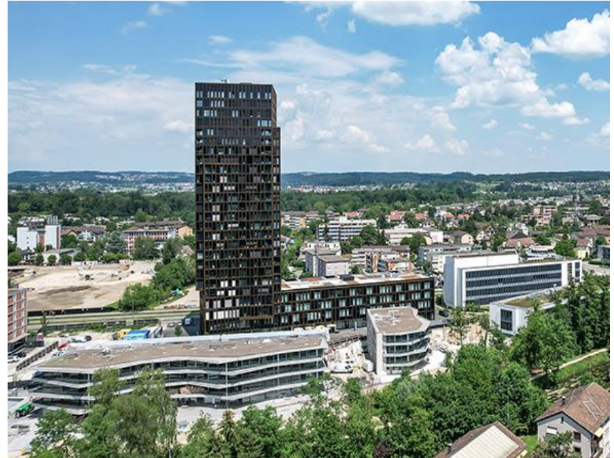
Giessenturm, Dübendorf, Schweiz: von Implemia (Real Estate und Buildings) realisiert, von Wincasa innerhalb der Gruppe bewirtschaftet
