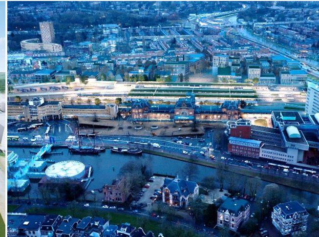
Bahnhof-Erweiterung, Geotechnik (BBV Systems), Groningen, Niederlande
