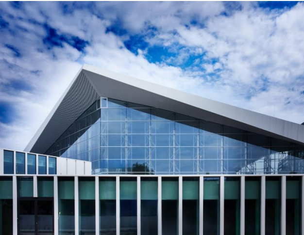
Alster Schwimmhalle, Fassadentechnik, Hamburg, Deutschland
