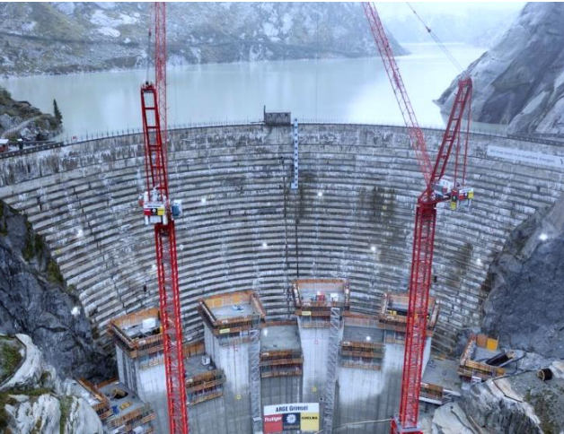
Staumauer «Spitallamm», Grimsel, Schweiz
