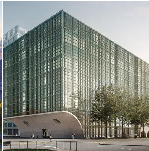
Laborgebäude Departement Biomedizin, Basel, Schweiz
