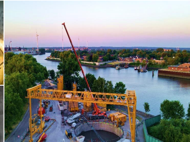
Fernwärmehunnel unter der Elbe, Hamburg, Deutschland
