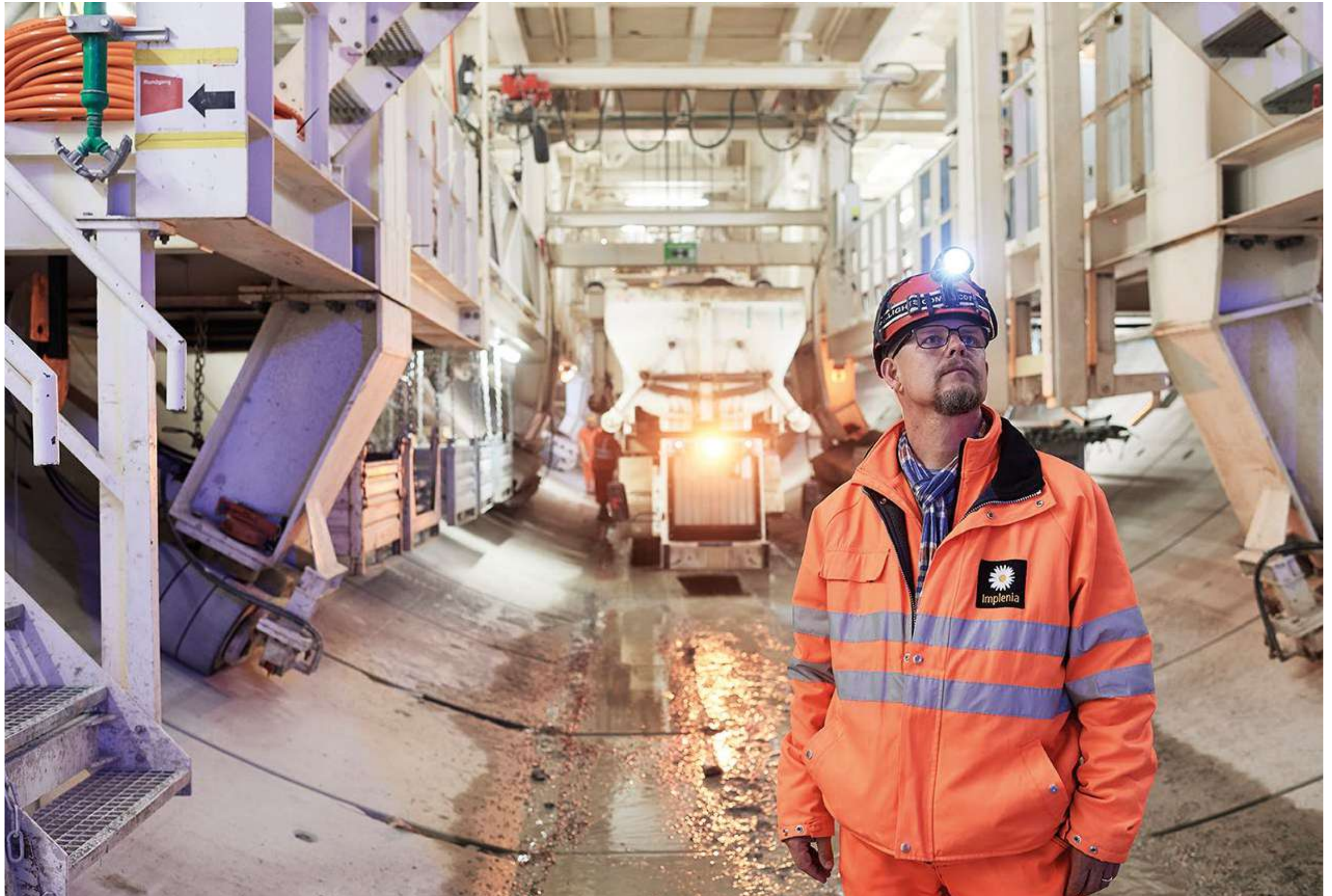
Vortrieb mit Tunnelbohrmaschine im Fels (Bözbergbahntunnel, Kanton Aargau, Schweiz)
