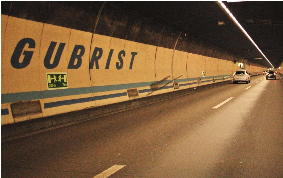
Der Gubristtunnel ist einer der am stärksten befahrenen Strassentunnel der Schweiz und die beiden bestehenden Röhren sind seit 1985 in Betrieb (Bild: ©ASTRA).
