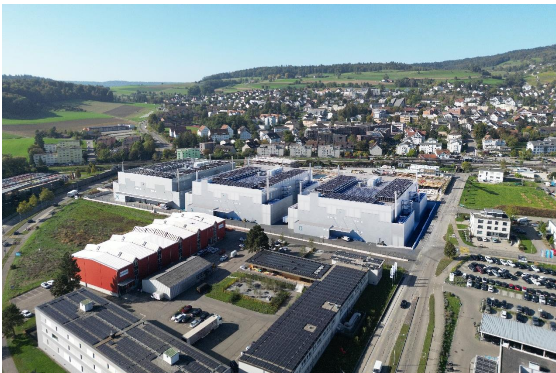
Implenia baut zwei weitere Rechenzentren für den Green Metro-Campus in Dielsdorf bei Zürich (Bild: © zvg. bfarchitekten.ch).
