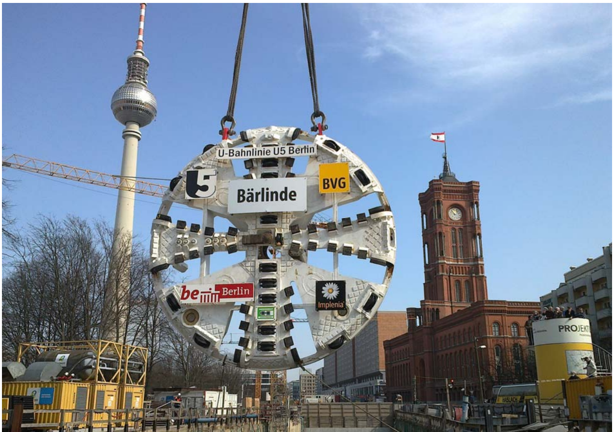
Die 74 Meter lange und 700 Tonnen schwere Tunnelbohrmaschine „Bärinde“ arbeitete sich nach Unterquerung von Spree, Humboldtforum und Spreekanal unterhalb des Boulevards Unter den Linden hindurch bis zum U-Bahnhof Brandenburger Tor. Mehr Informationen zu „Bärinde“ finden Sie hier . (Bild: Antonio Reetz-Graudenz)
